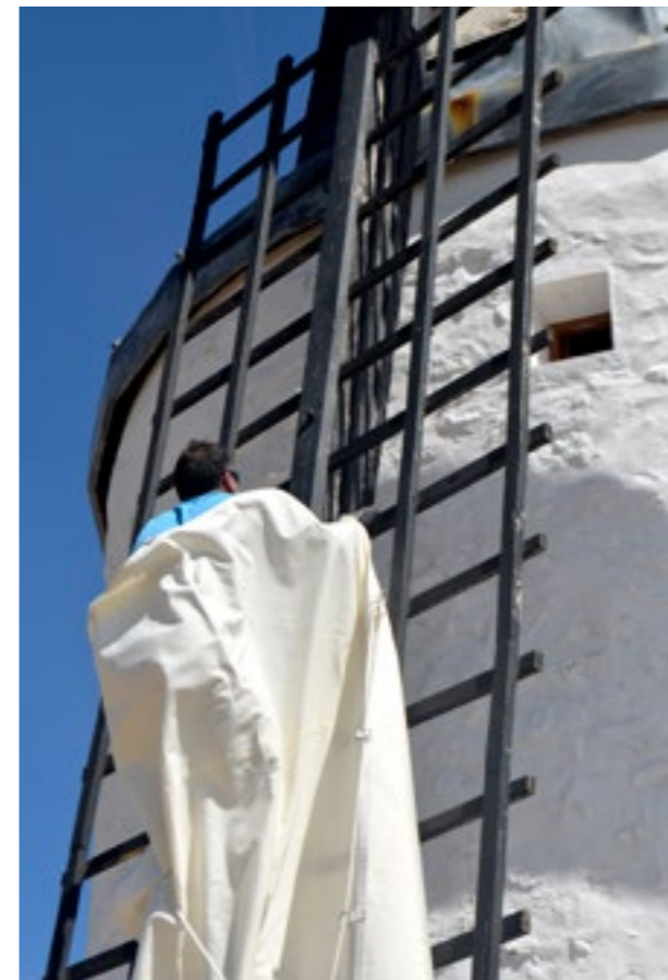
Colocación de los lienzos en las velas, que son las partes de las aspas que reciben directamente el viento
