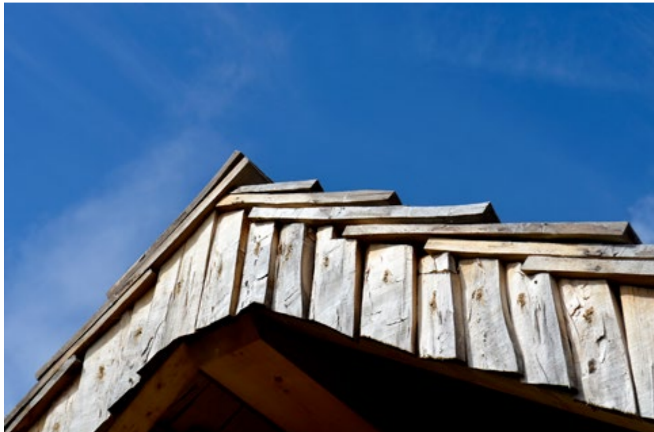
Remate de una cubierta de tablilla de madera de haya en Garralda, Navarra
