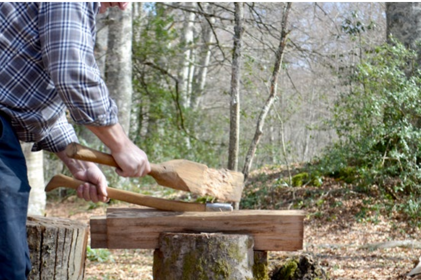
Troceado de la madera con el hacha para la obtención de las tablillas
