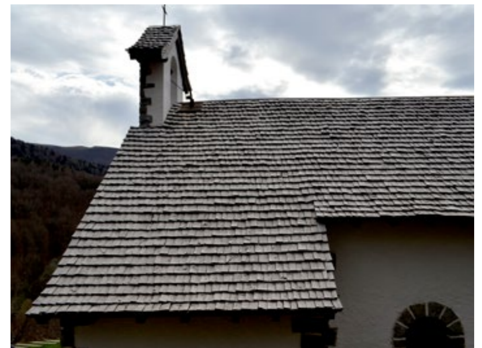
Cubierta de tablilla de madera de haya de la ermita de la Virgen de las Nieves
