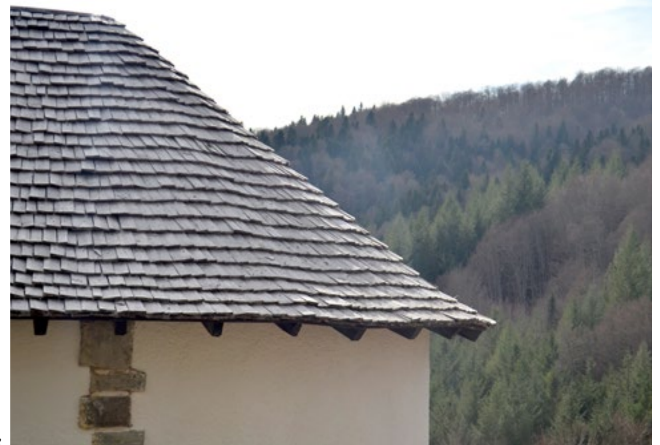
2. Cubierta de tablillas de madera de haya de la ermita de la Virgen de las Nieves, en la Selva de Irati, Navarra
